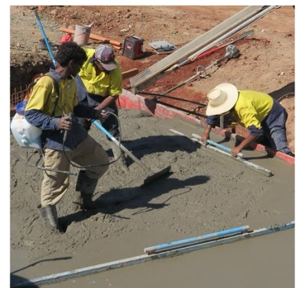
Forming concrete apron after pour
