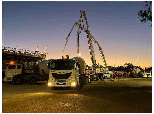
Early concrete pour
